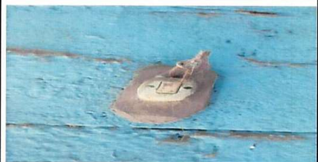
Instalación de unidades de fuerza, tomacorrientes, incluye cable electrico.
