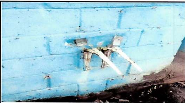
Sustitución de lavamanos por lavamanos de concreto.
