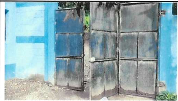
Sustitución de porton de metal por porton de metal.
