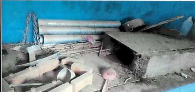
Sustitución de estufa rural completa, incluye chimenea y plancha de metal
