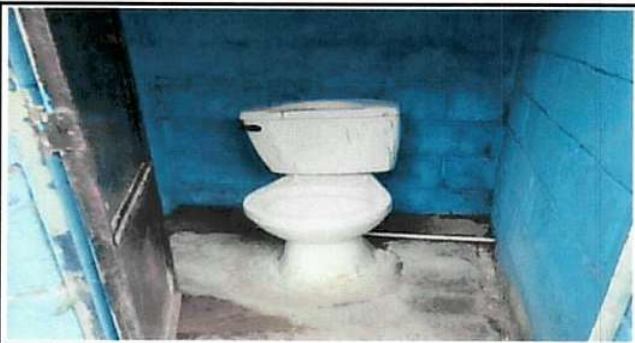
Sustitución de inodoro más accesorios.
