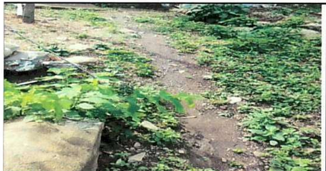
Sustitución de piso de torta de concreto por concreto.
